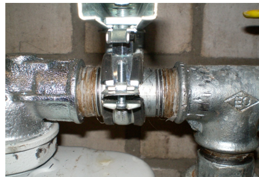
Abbildung 2 u. 3) Mangelbilder bei der Verwendung von Dichtband und Hanf
