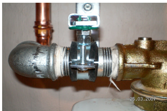
Abbildung 2 u. 3) Mangelbilder bei der Verwendung von Dichtband und Hanf
